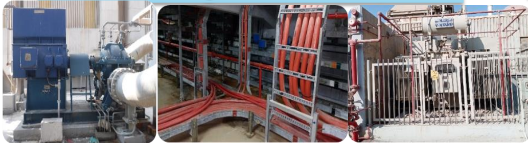
✓ محولات كهربائية و مفاتيح كهربائية و كابلات.
